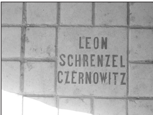
Фото 3. Декоративна керамічна плитка з майстерні Леона Шренцеля у Чернівцях. У парадних багатьох історичних будівель міста збережена декоративна аутентична керамічна плитка одного з перших майстрів-керамістів міста Леона Шренцеля. Світлина авторки. 2007р.
