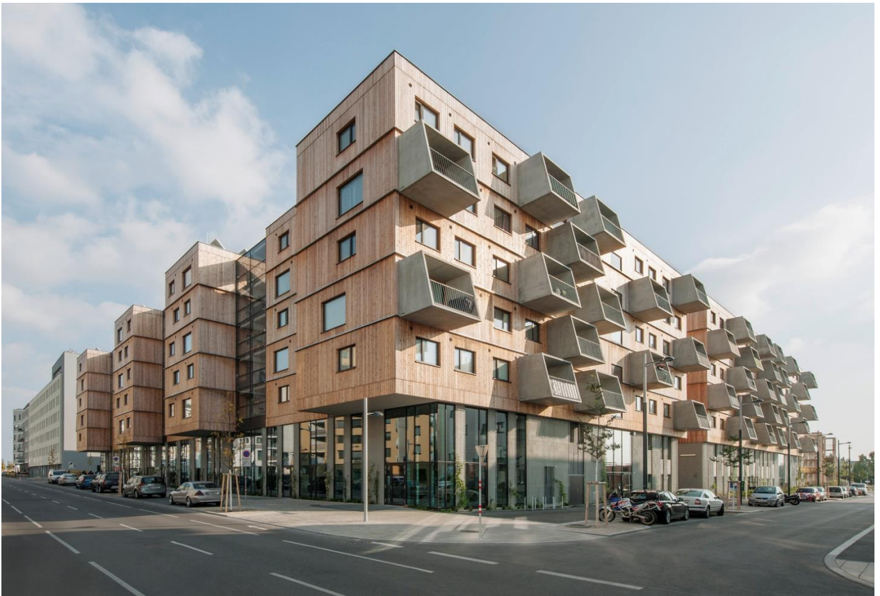
Рис. 2.1.1. Загальний вигляд комплексу [1]
