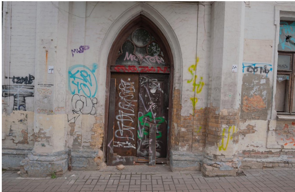
Рис. 3.18. Спеціальні марки на будівлі [Nikon D700]
