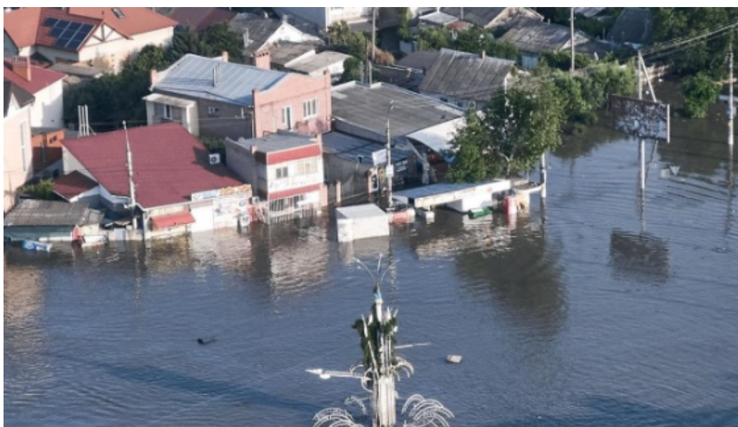
Рис. 1.8 Затоплені житлові будинки внаслідок підриву Каховської ГЕС
