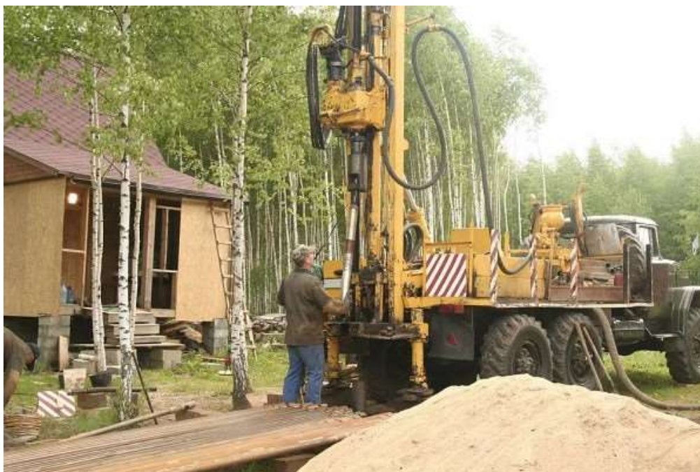
Рис. 27.1. Процес колонкового буріння свердловин
