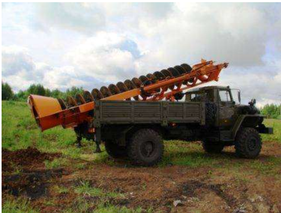
27.6. Бурова установка для шнекового буріння свердловин
