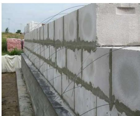
**T<sub>p</sub>-2** - стена из бетонных (пено-, газо-, керамзитобетонных) блоков. Стены из бетонных блоков долговечны, огнеупорны, не подвержены гниению и воздействию вредителей. Бетонные блоки легкие в обработке, что позволяет возводить стены сложной конфигурации. Стены из бетонных блоков обладают большой теплоемкостью.
