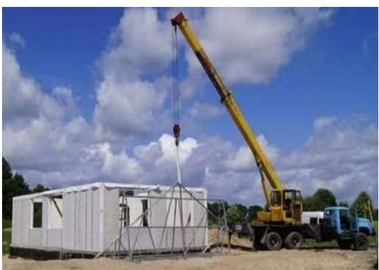
**T<sub>p</sub>-3** - сэндвич панель из легкого стального каркаса. Была рассмотрена стеновая панель компании «Меттэм», которая состоит из стального термо-профильного каркаса, окрашенной фибропементной плиты и гипсо-стружечной плиты в качестве наружней и внутренней обшивки и базальтового утеплителя.
