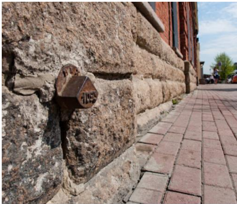
Рис. 2.6.2. Стіновий репер нівелірної мережі
