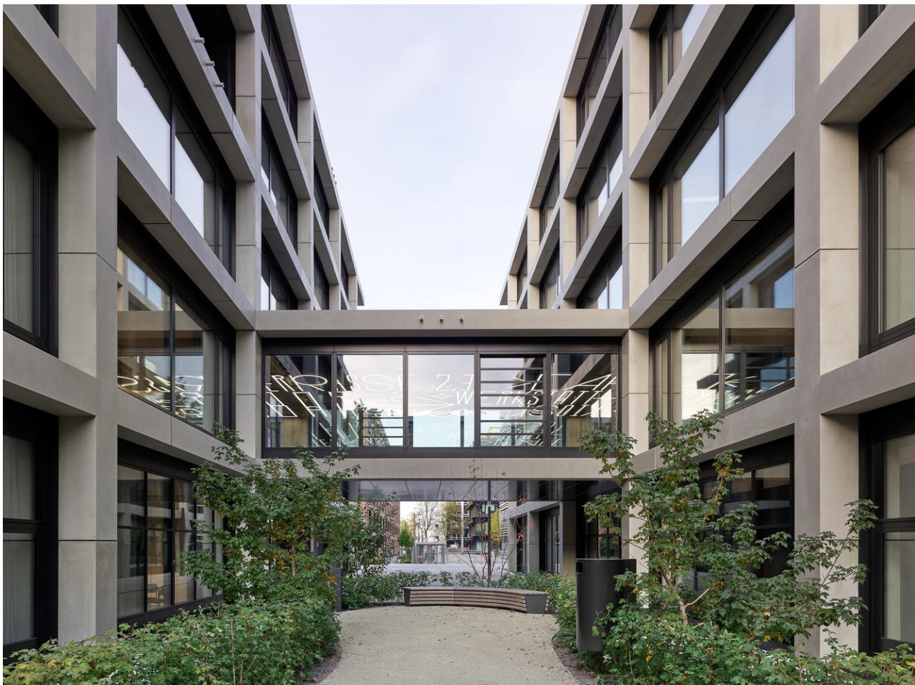
Рис. 2.2 Міст, який з'єднує три будівлі «iCampus Munich» між собою [1]
