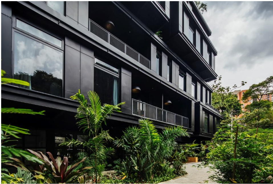
Фасадні матеріали будівлі (рис. 2.25) [18].
