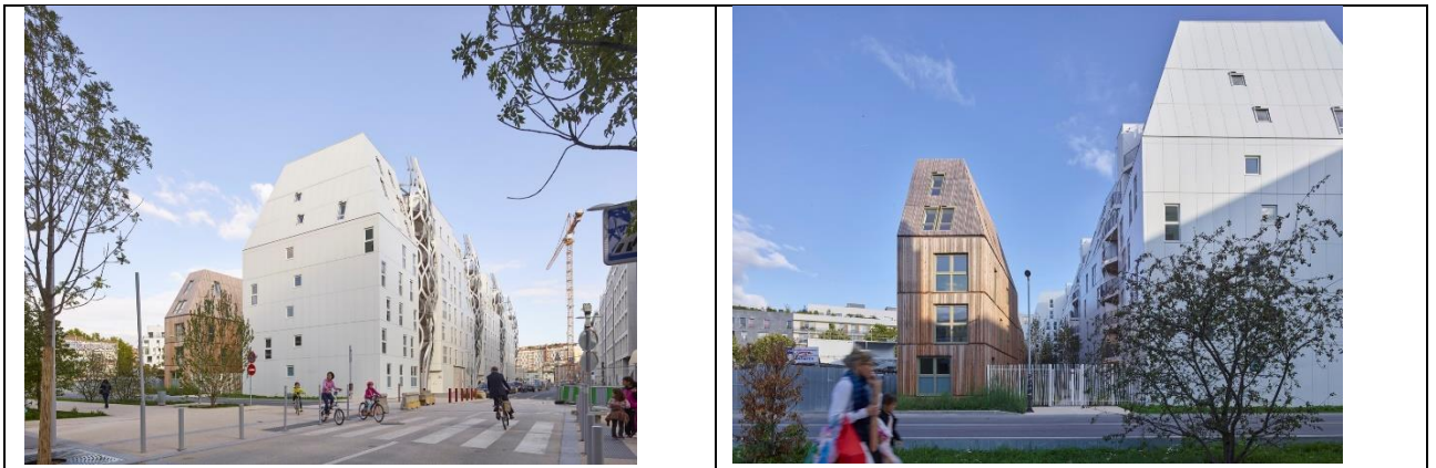
Рис.1.28 та рис.1.29. Загальний вигляд будівлі «Rive Seine Building» [32]
