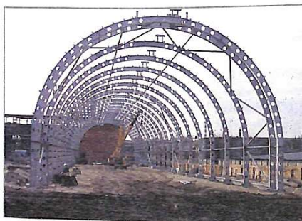
Будівництво спорткомплексу “Монітор” – конструкції покриття тенісних кортів
