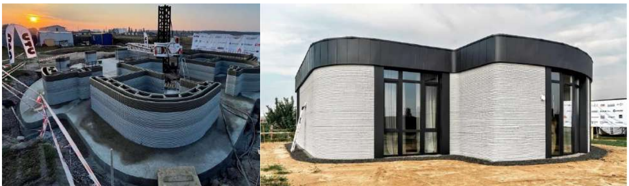
Рис. 1.7 Дім в Ірпені, зведений 3D-друком
