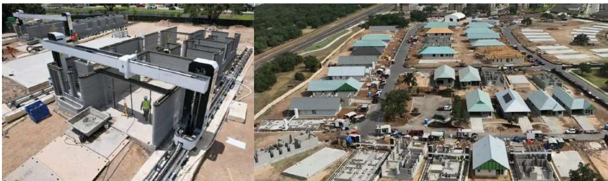
Рис. 1.4 Зведення кварталу у Техасі за допомогою 3-принтера
