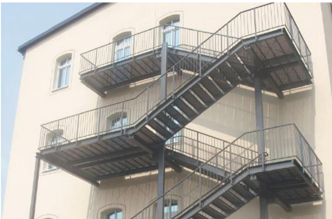
Рис. 4.2.1.1. Зовнішні протипожежні сходи.
