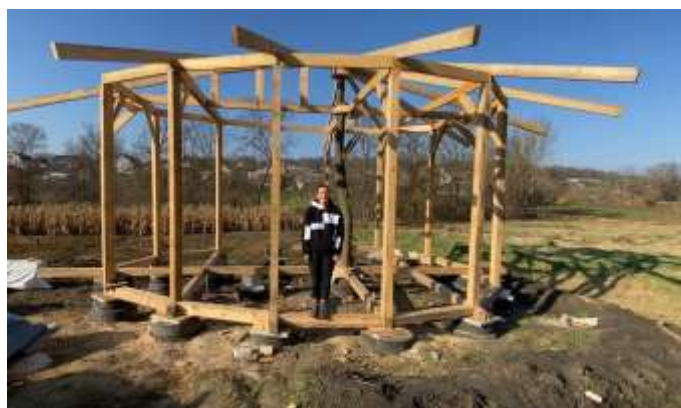
Рис 1.1.4 «Дім зі сміття»: фундамент на колесах та каркас із деревини[2]
