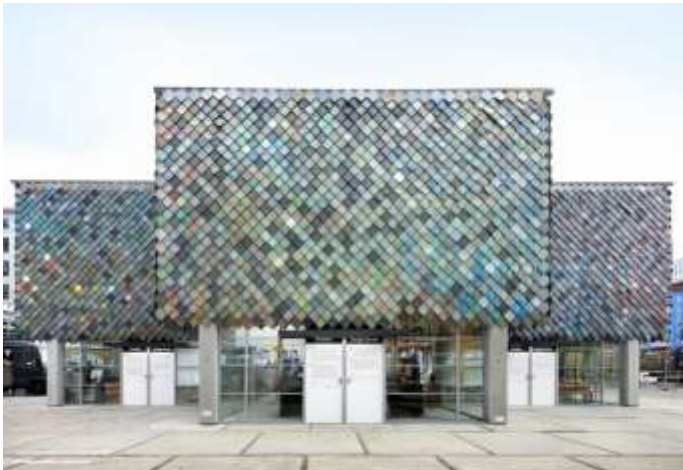
Рис 1.1.8 Фасад з переробленого пластику народного павільйону / бюро SLA + Overtreders W[5]
