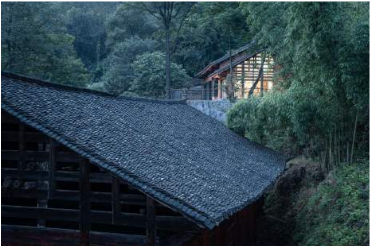
Рис. 1.2.44 Фрагмент старого будинку
