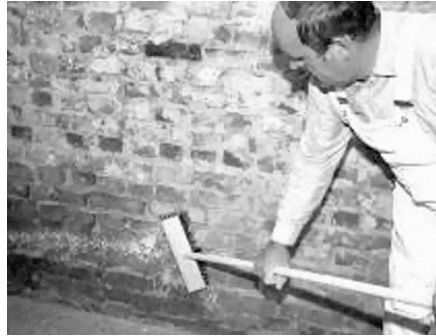
Рис. 3.1.1. Видалення неміцних ділянок поверхні, яка гідроізолюється.
