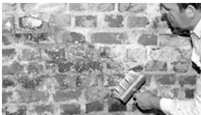
Рис. 3.2.1. Нанесення ґрунтовки.
