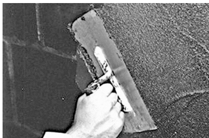
Рис. 3.2.4. Нанесення третього шару гідроізоляції.
