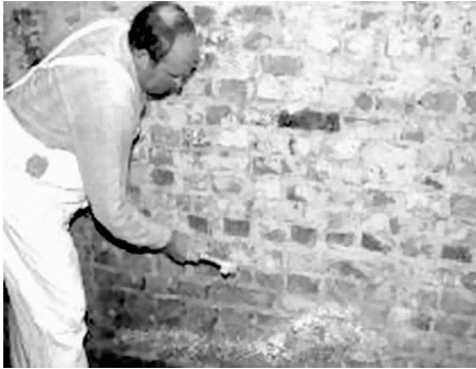
Рис. 3.1.1. Видалення неміцних ділянок поверхні, яка гідроізолюється.
