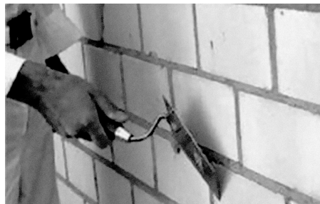
Рис. 3.1.2. Підготовка поверхні, вирівнювання її від надлишків розчину.
