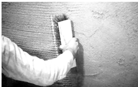
Рис. 3.2.3. Нанесення першого шару гідроізоляції.
