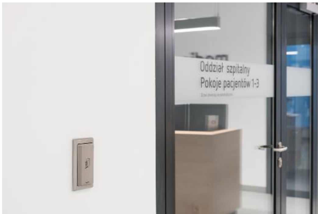
Рисунок 7.4. Двері автоматизовані з механізмом натискання
