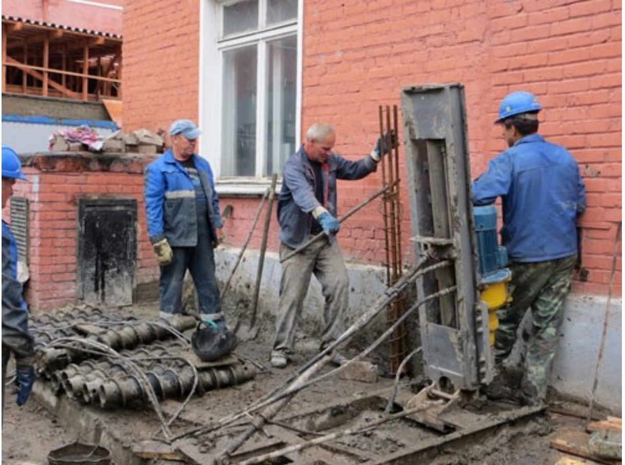
Установка армокаркаса в бурин'єкційну палю
