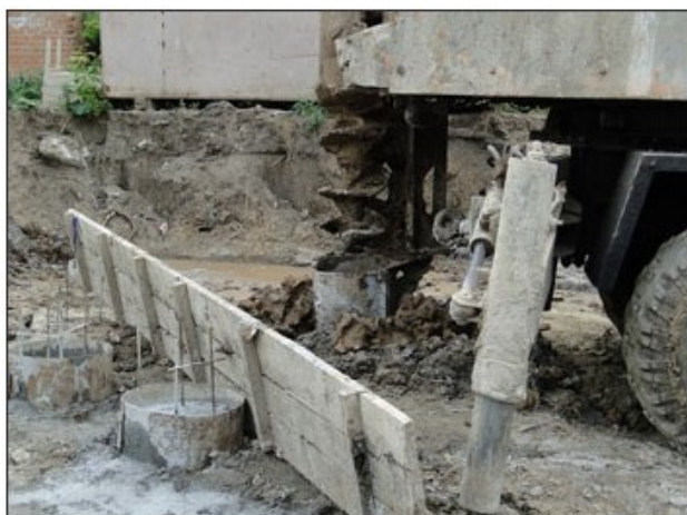
Заливка бетону в металевий каркас буроін'єкційні палі
