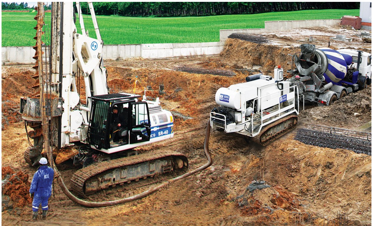
Бетонування буроін'єкційних палей
