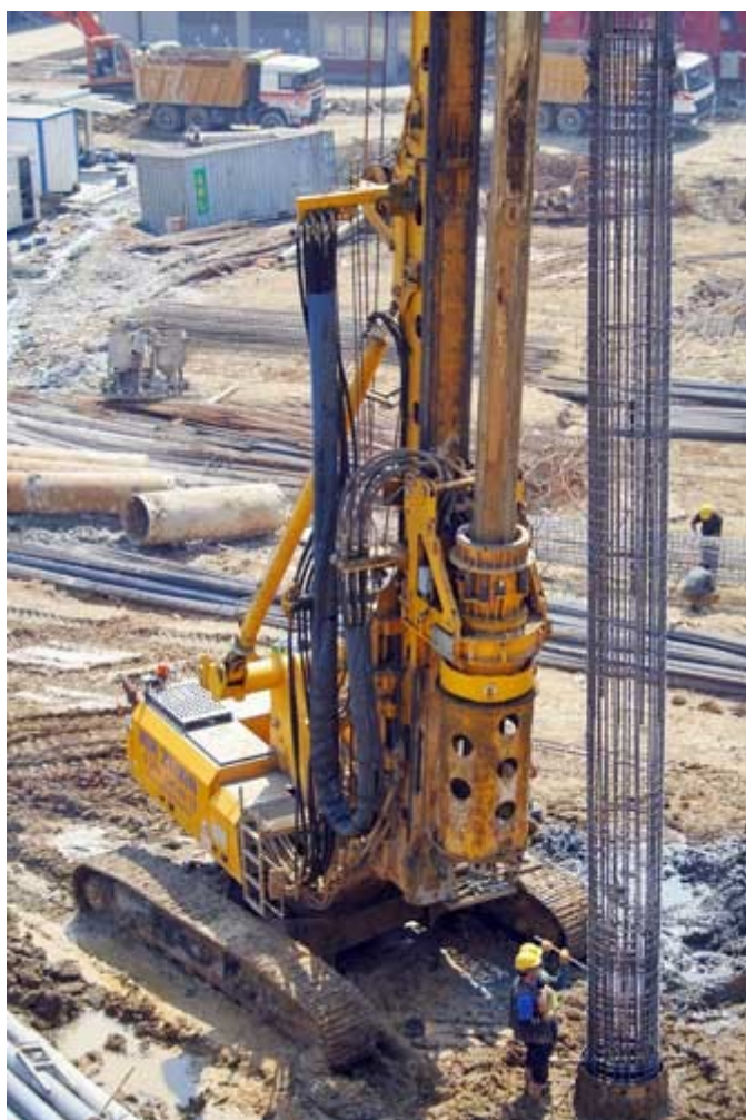
Установка армокаркаса у свердловину
