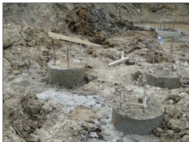
Заливка бетону в металевий каркас буроін'єкційні палі
