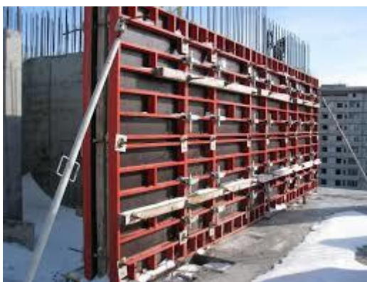
Рис.3.19 Опалубка для зведення монолітних стін
