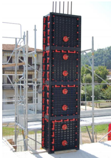
Рис.3.12.Опалубка для квадратних колон
