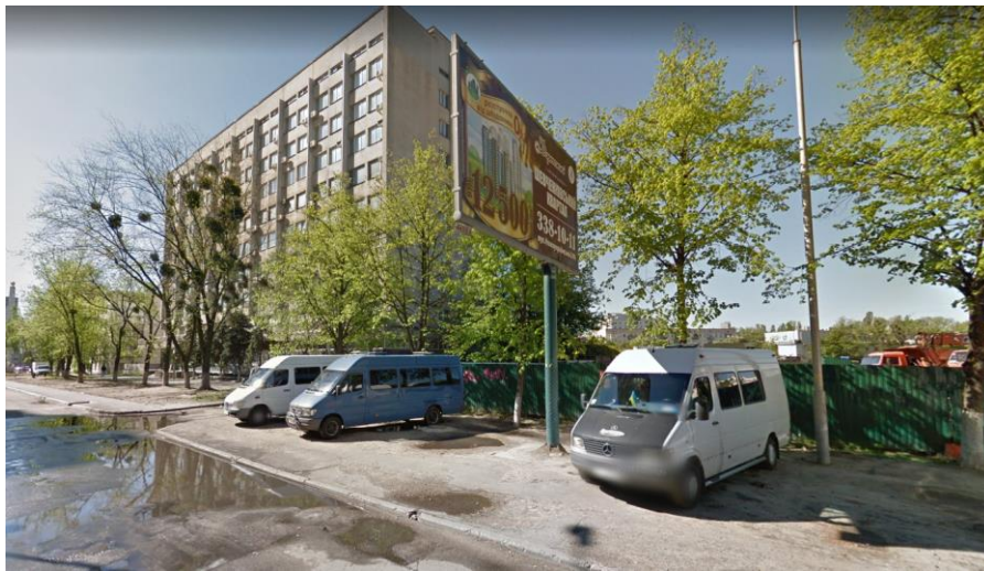
Рис. 3.3. Фотофіксація ділянки забудови. Оточуюча забудова
