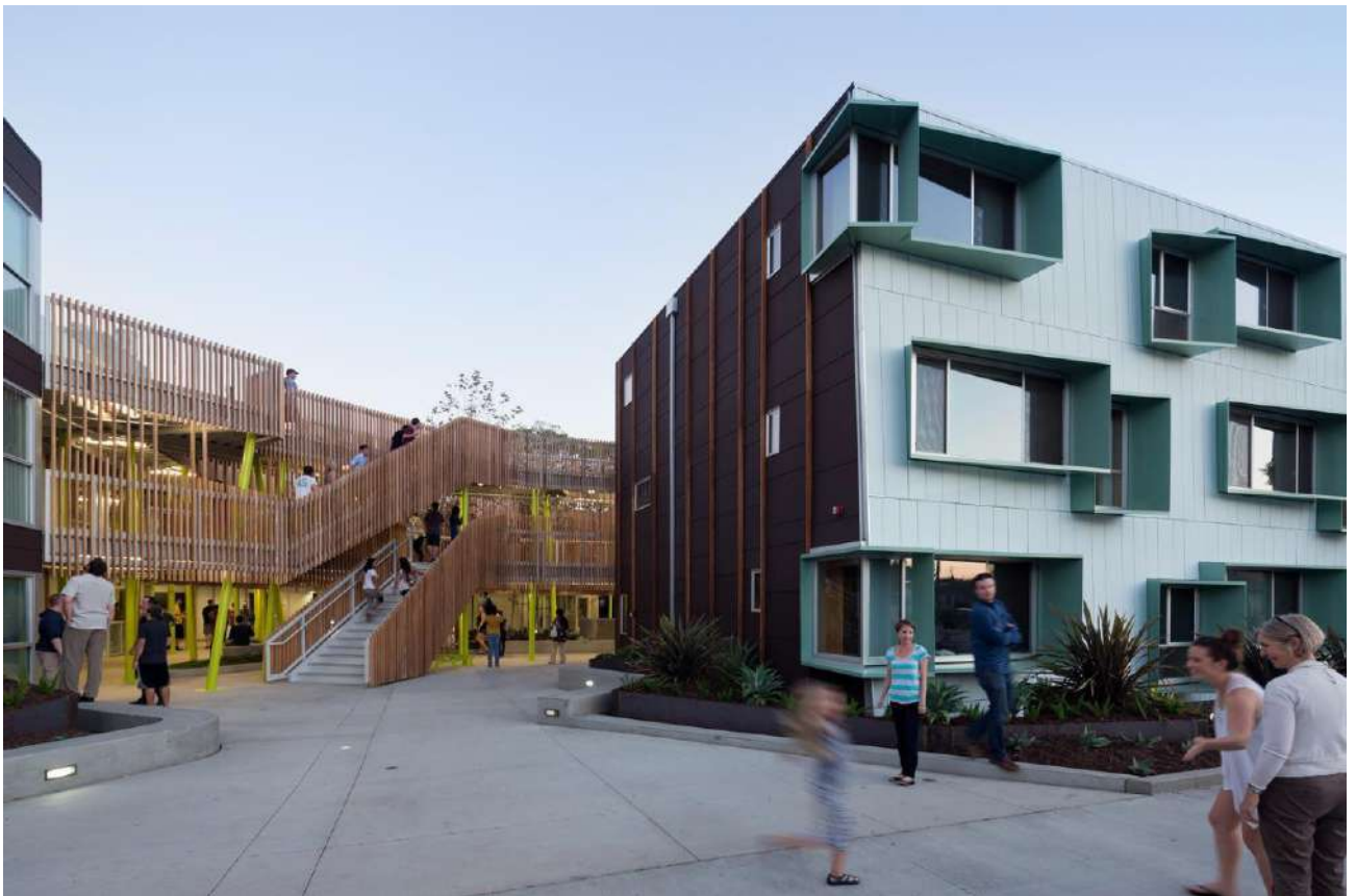
Рис. 2.8. Вхід у двір житлового комплексу Broadway Affordable Housing, архітектурне бюро «Kevin Daly Architects», https://www.archdaily.com/503233/broadway-housing-kevin-daly-architects
