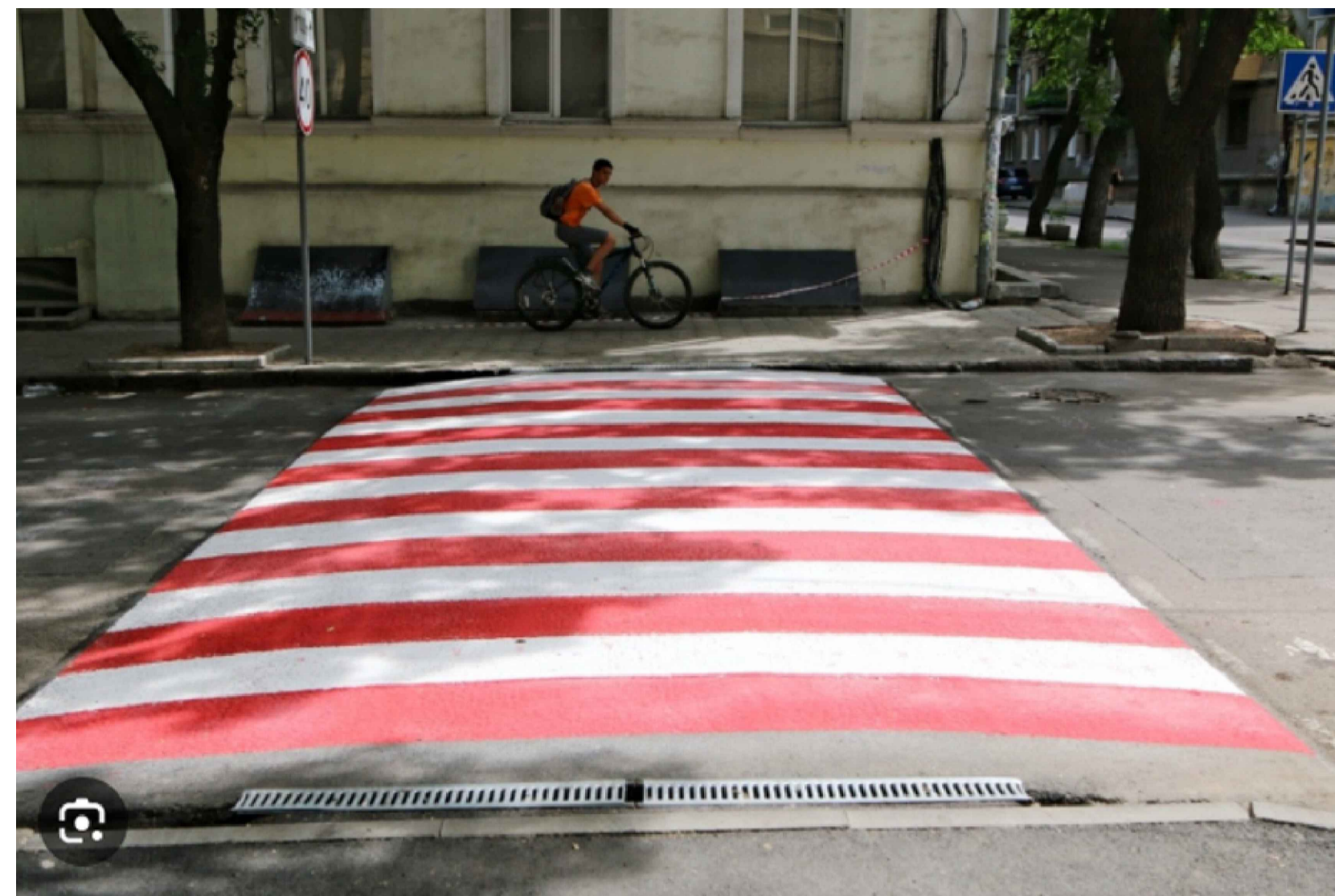
Підвищені пішохідні переходи (raised crosswalks):
