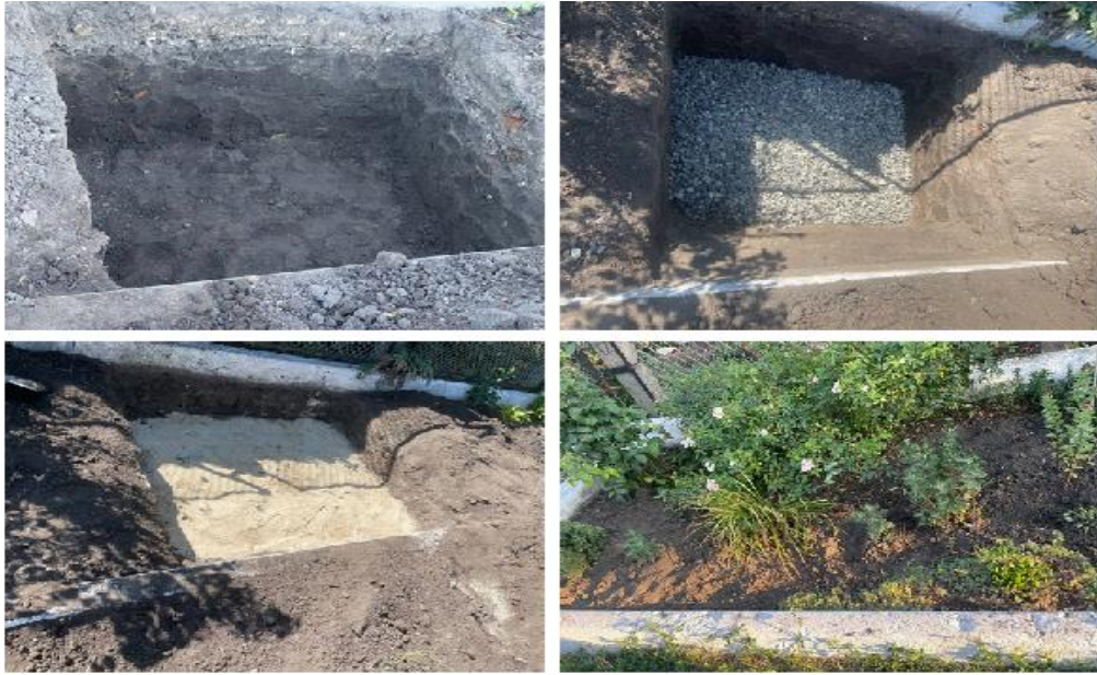
Рисунок. 18. Етапи будівництва пілотної конструкції дощового саду в Київській області
