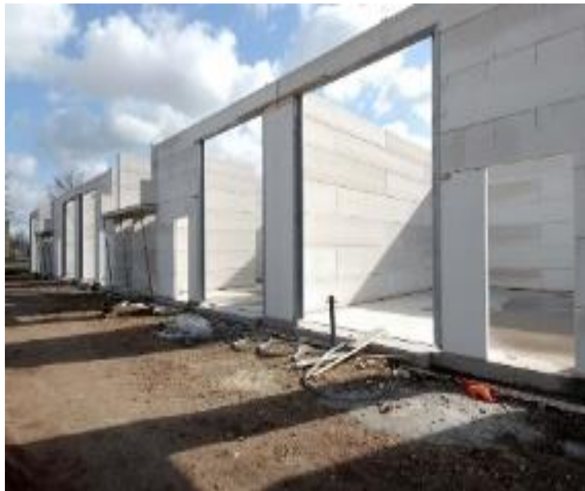
Рис. 3.2 Споруда, зведена з газобетонних стінових панелей
