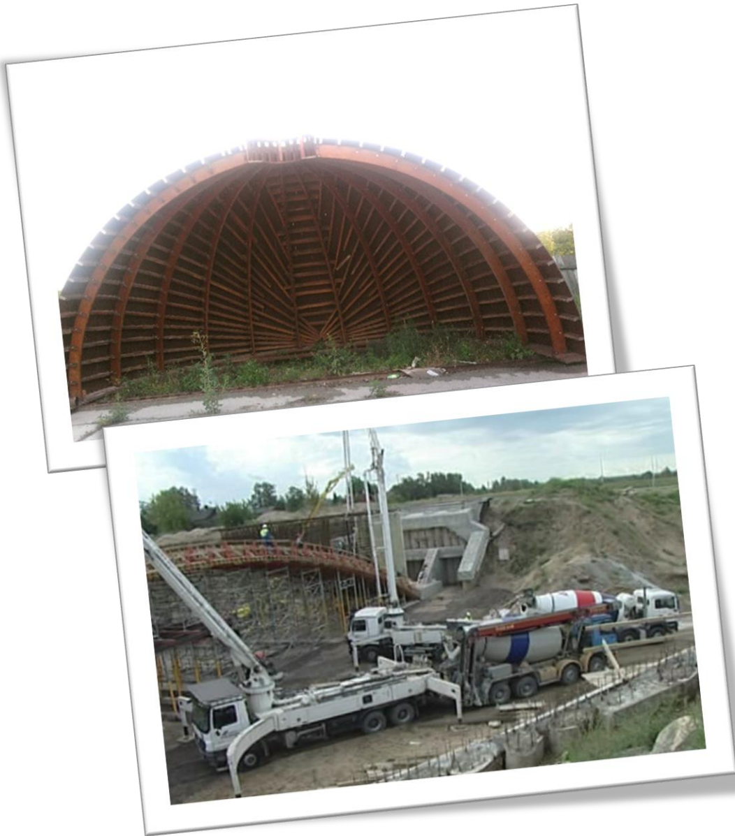
Рис. 25. Бетонування арок і колон
