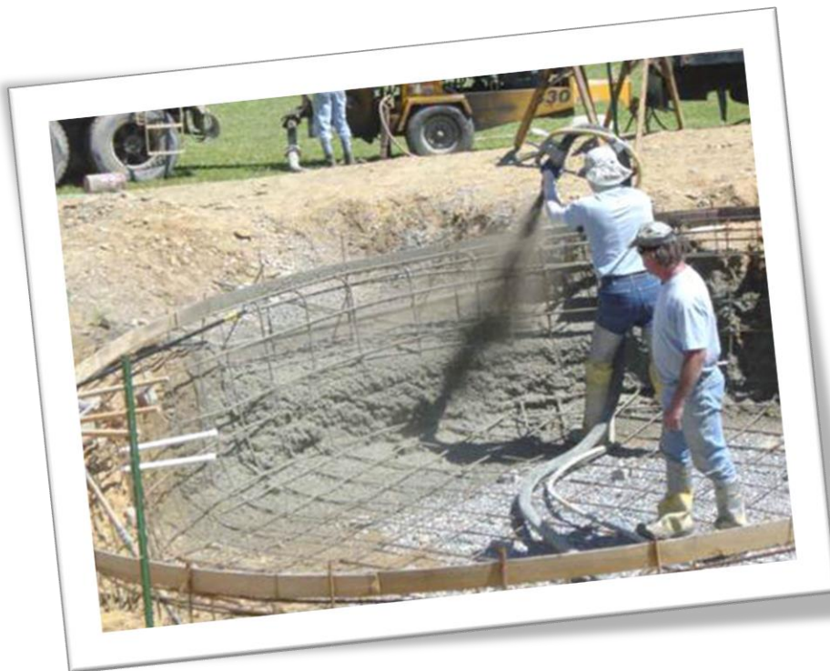
Рис. 19. Укладання і ущільнення бетонної суміші торкретуванням (див. також с. 26)
