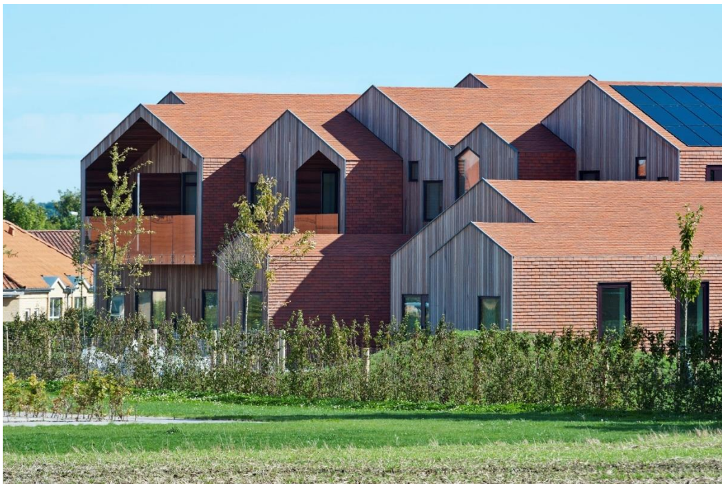
Рис. 2.6. Загальний вигляд на будівлю
