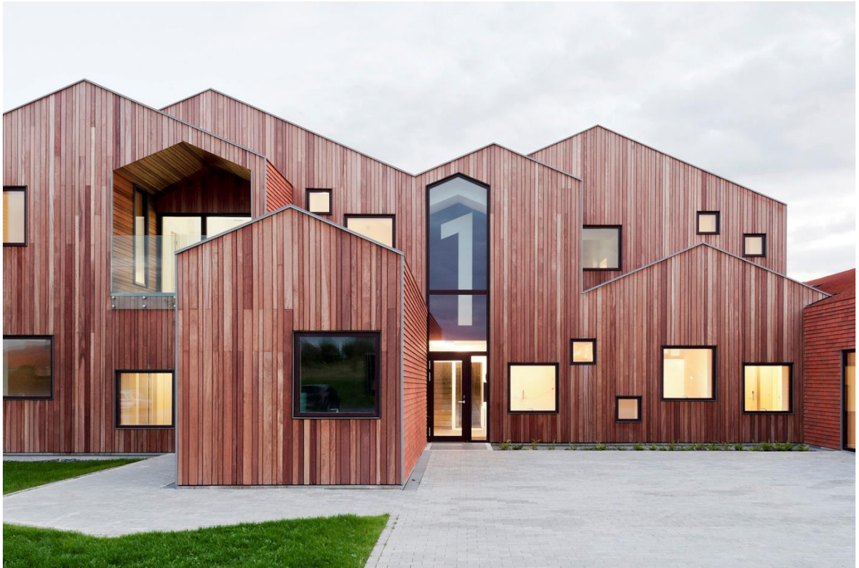
Рис. 2.3. Загальний вигляд будівлі
