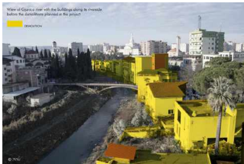
Рис.1.2.15 Демонтаж забудови за проектом [66]
