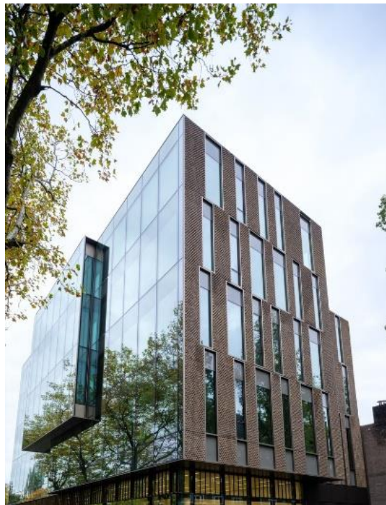
Рис. 2.9. Фасад будівлі офісу Apolloaan 171 [15]
