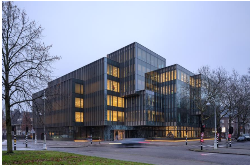
Рис. 2.8. Фасад будівлі офісу Apolloaan 171 [15]
