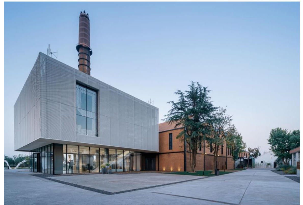
Ремонт колишнього заводу як новий культурний центр, Шанхай, Китай
