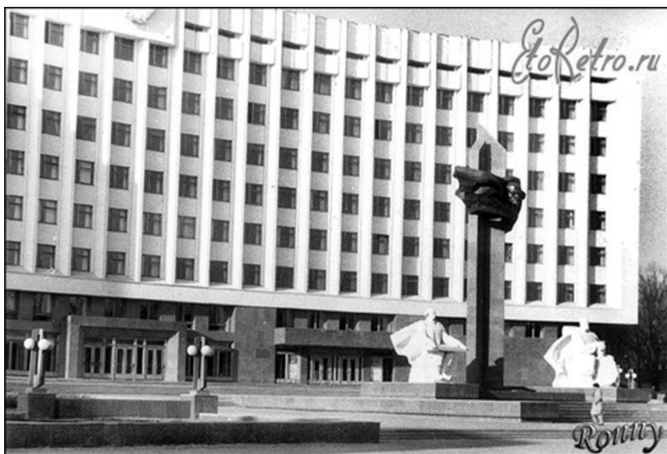
Будівля міськвиконкому, обласної та міської рад (1980-ті роки)
