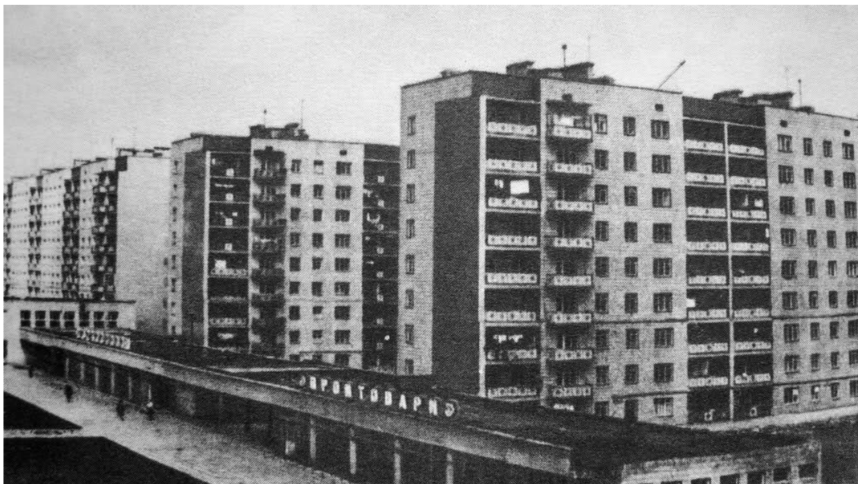
Серії 111-96 типового житлового 9-поверхового будинку
