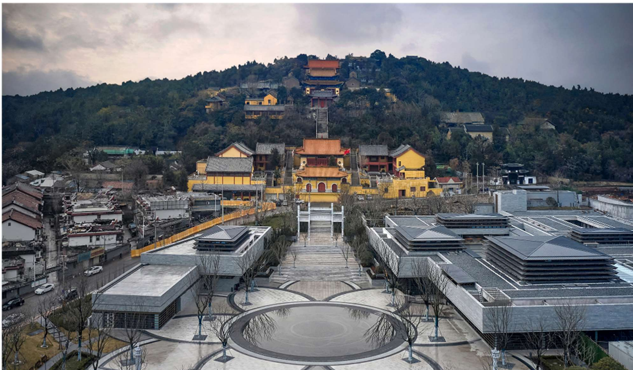
Рис. 2.16. Загальний вигляд будівлі [4]
