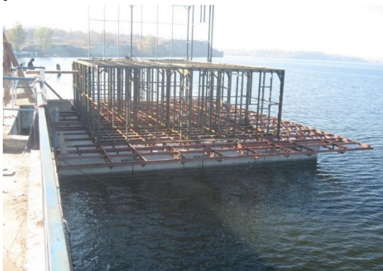
Рис.6.1, рис.6.2 Приклад металевого каркасу для приватного будинку на воді та транспортування будинку катером [63].
