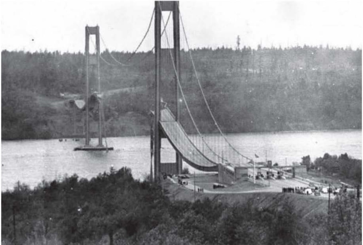
Рис.1.5. Руйнування вантового мосту в м. Такома, США
