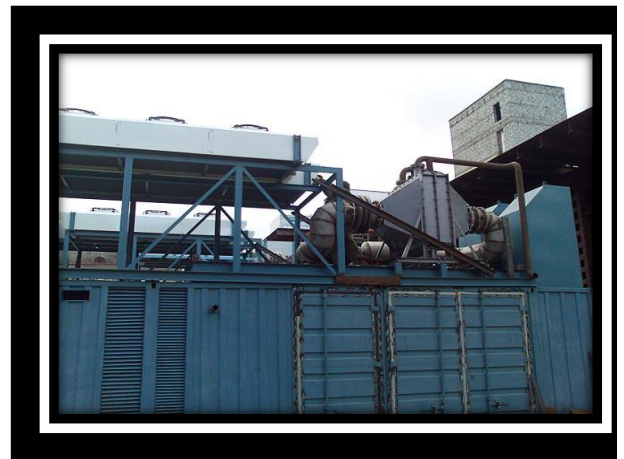
Рис. 3.2. КГУ змонтована відкрито на рамі для розміщення в пристосованому приміщенні
