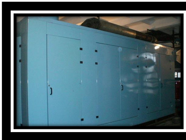
Рис. 3.2. КГУ змонтована відкрито на рамі для розміщення в пристосованому приміщенні
