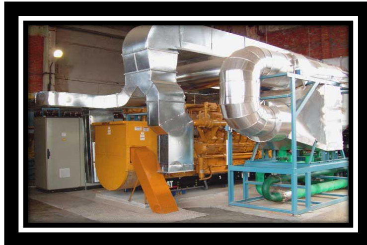
Рис. 3.2. КГУ змонтована відкрито на рамі для розміщення в пристосованому приміщенні
