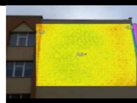
Рисунок 3.1 - Тепловізійне обстеження навчально закладу № 24
