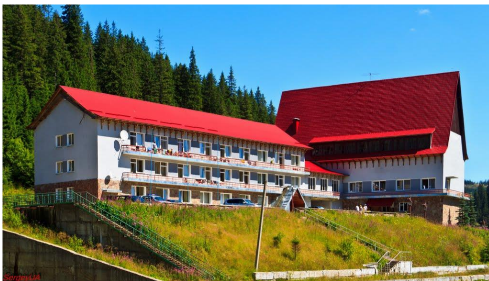
Рис. 2.2. Вид на головну будівлю [37]
