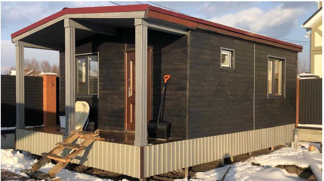
Рис.2.1. Проект будинку із СІП-панелей для внутрішньо переміщених осіб
