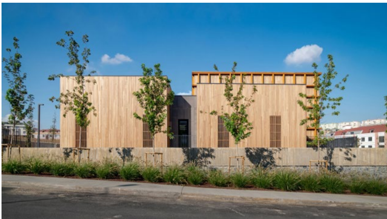
Рис. 2.8. Фасад будівлі зі сторони дороги [4]
