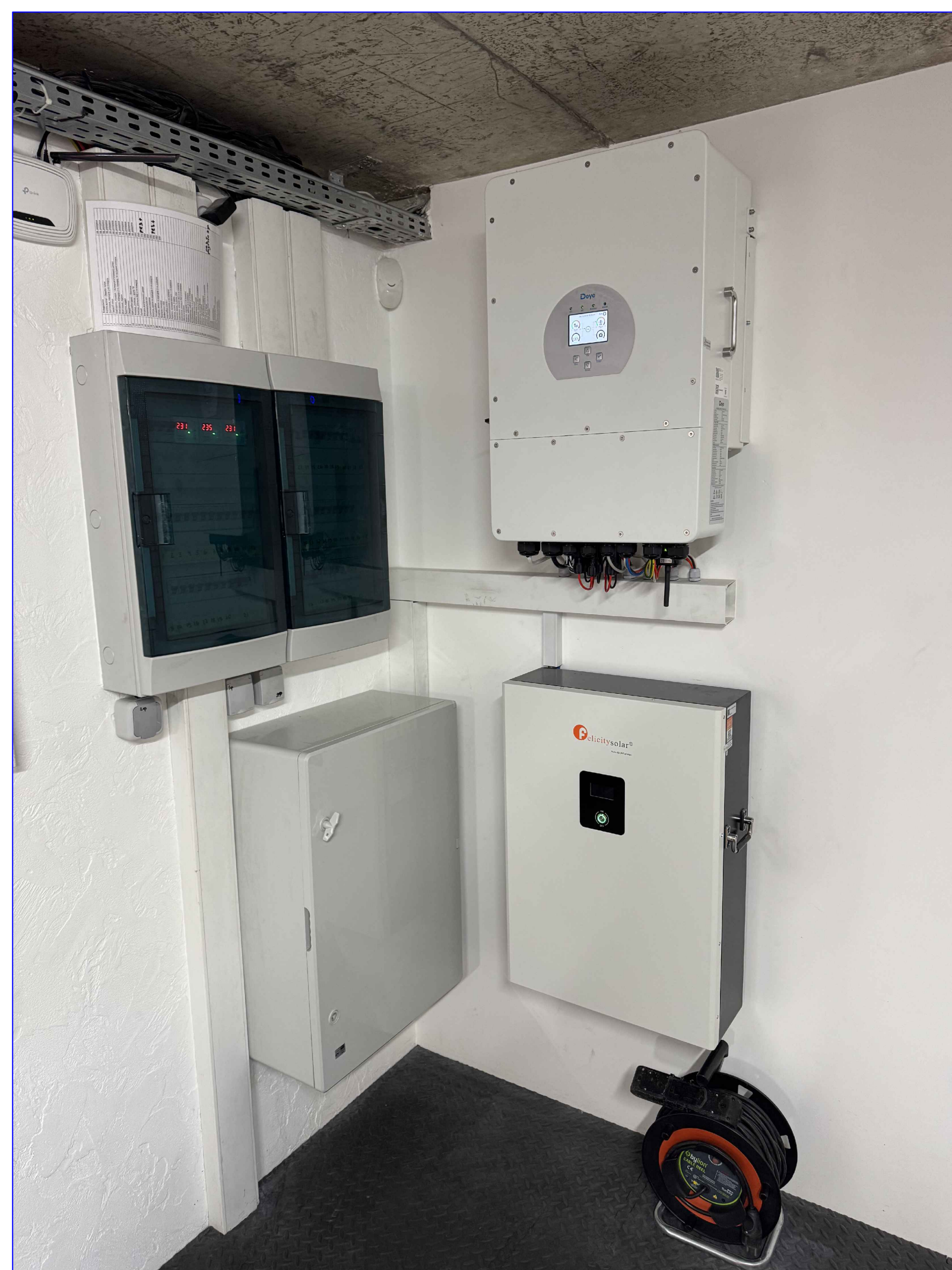
Система інвертора, акумулятора і обв'язки ФЕМ.
