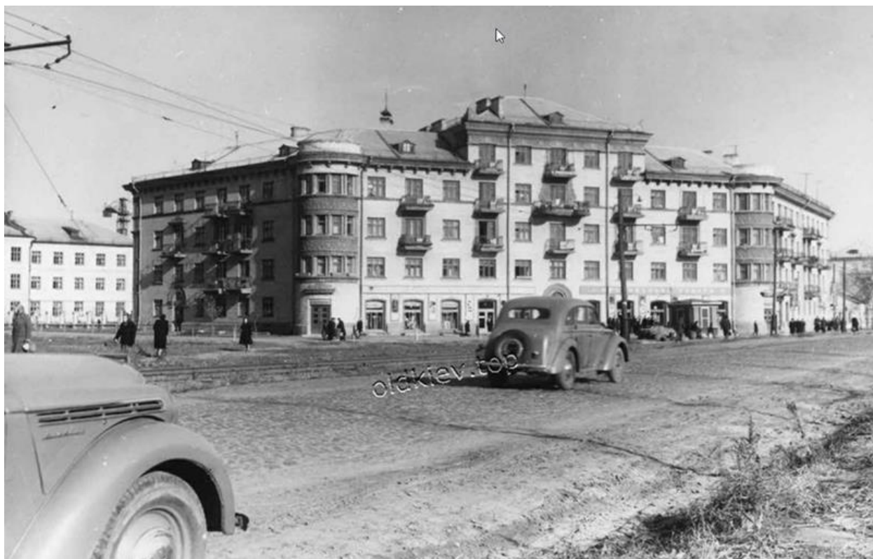
Рис. 3.1. Старовинне фото Севастопольської площі в м. Києві
