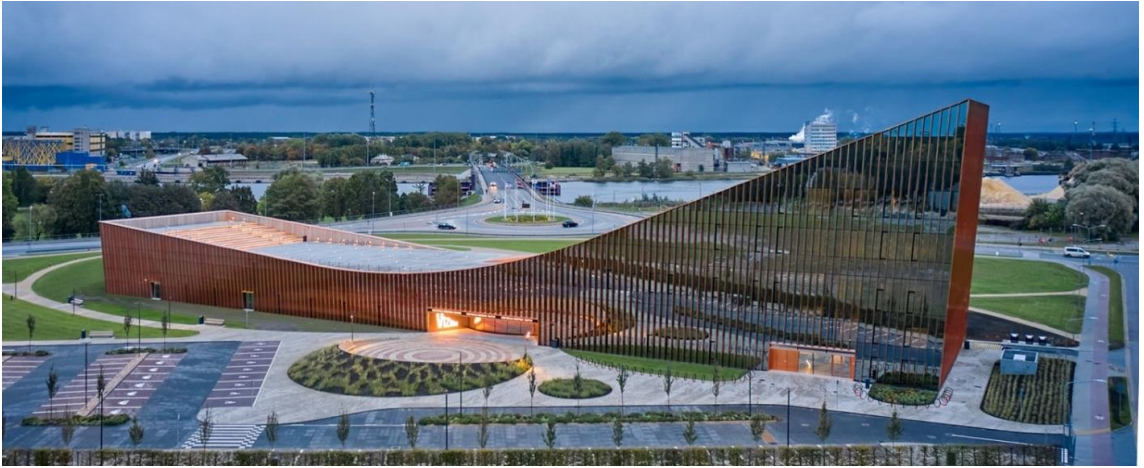
Рис. 2.17 Вид на будівлю з пташиного польоту [5]
