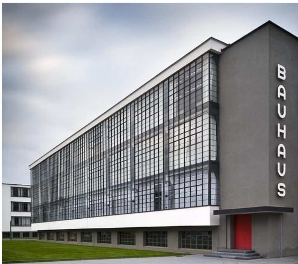
Рис. 2.3 Навісні скляні фасади [1]
