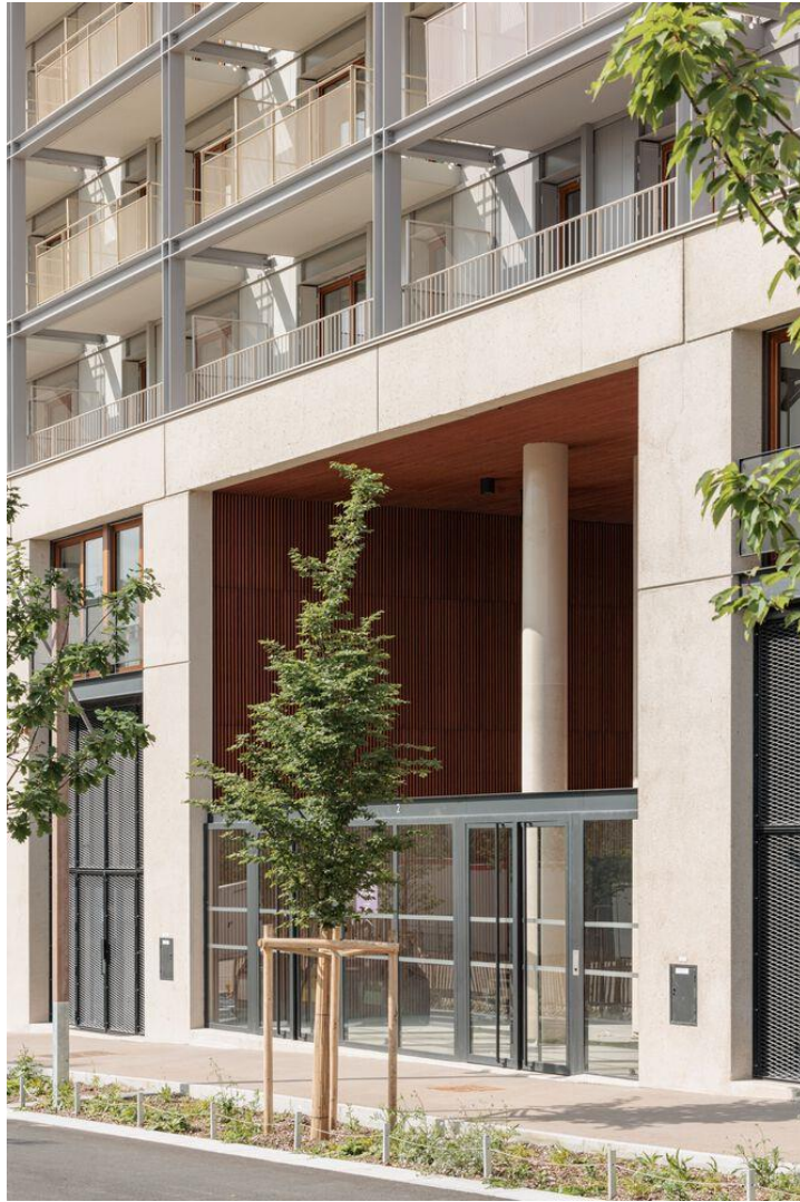
Рис. 2.12. Вхідна група. Приклад облицювання [6]
