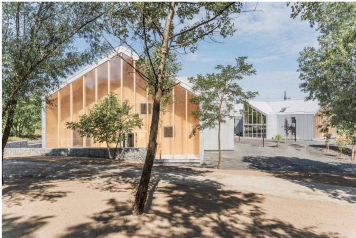
Рис. 7. Фасади будівель тимчасового житла для переселенців від Sulyk Architects
