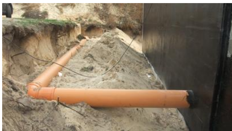
Рис 3.5. Приклад ґрунтового теплообмінника
