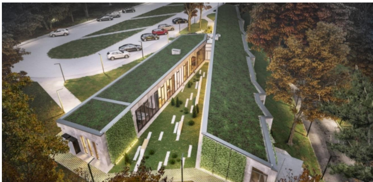
Рис. 2.3. Фасад адміністративної будівлі [17]
