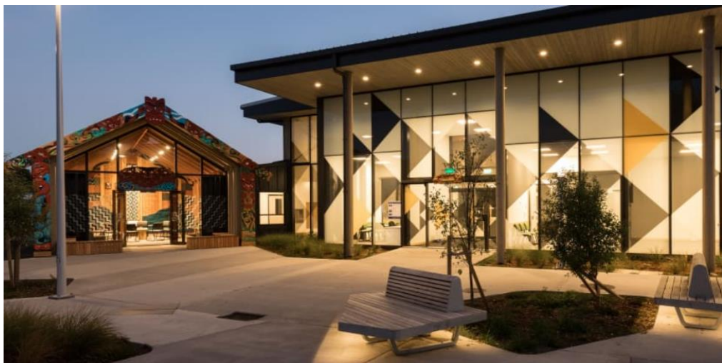
Рис. 1.16 Фасад лікарняного закладу
