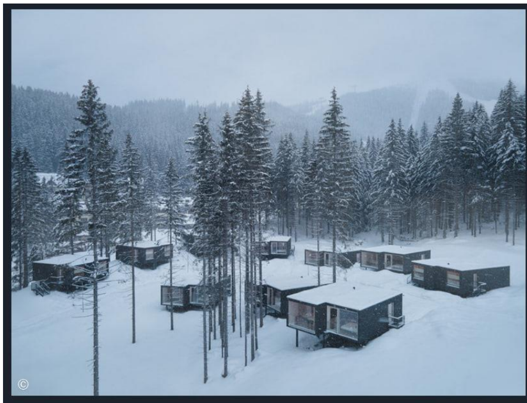
Рис. 2.4 Готельний комплекс Bjornson в місті Liptovský Mikuláš, Словачія
