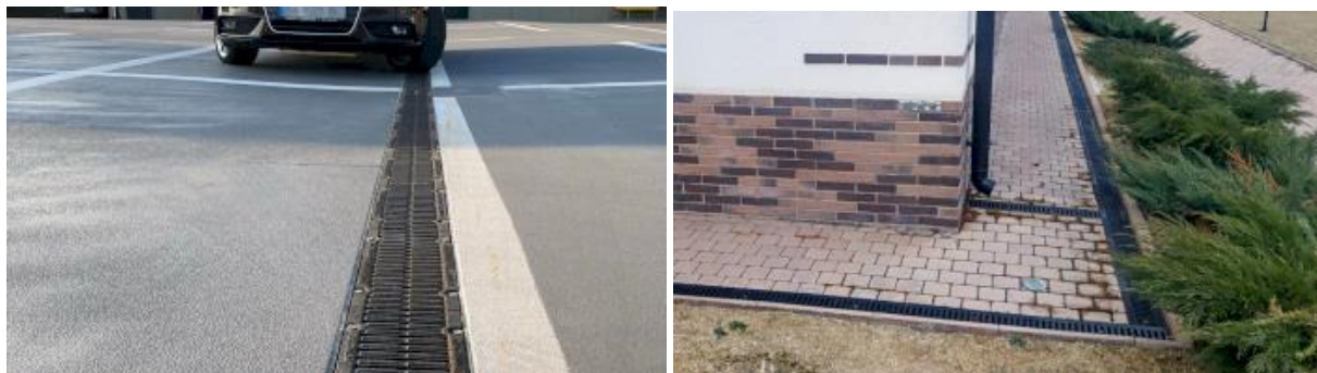
Рис.4.2. Приклад встановлення водовідвідних лотків
