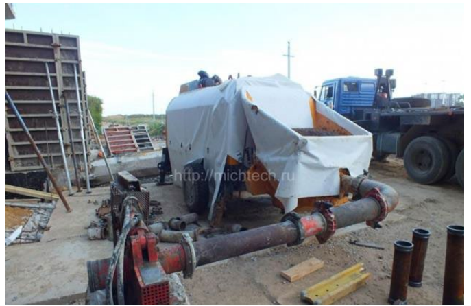
Рис. 2.8. Монтаж бетононасоса
