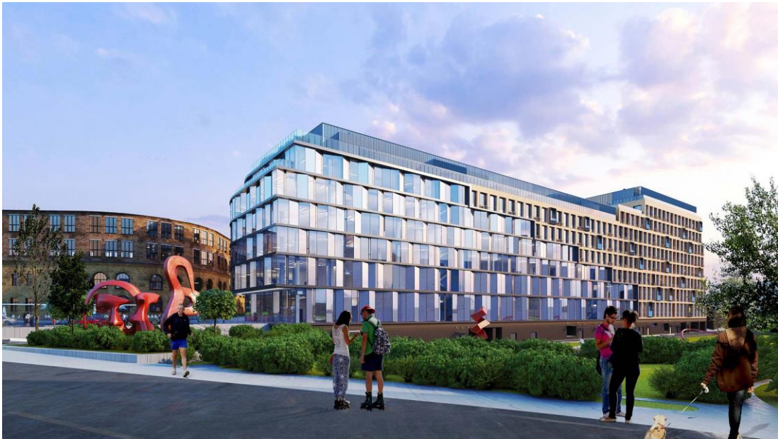
Рис.1.7. Реконструкція колишнього корпусу заводу «Арсенал».
